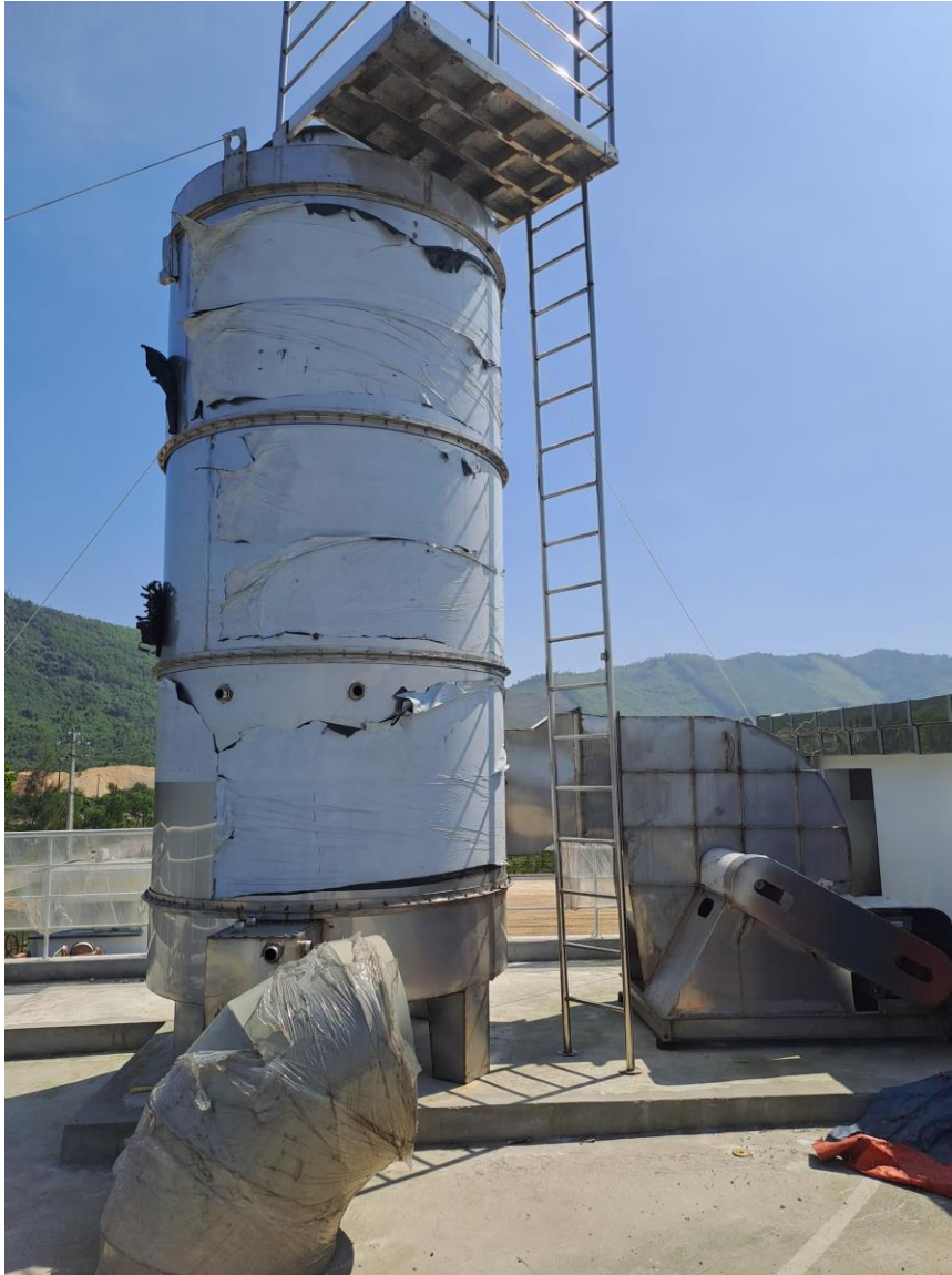
Hình 3.4. Hệ thống xử lý khí thải
